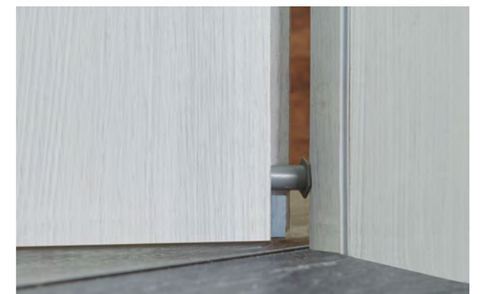
Auslöser für automatisch absenkende Bodendichtung
