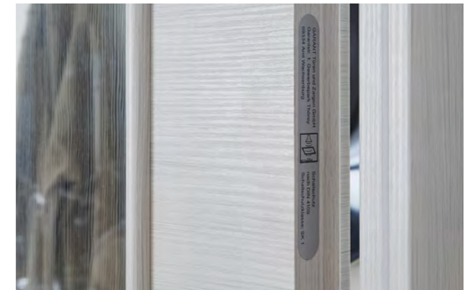
Funktionskennzeichnung im Türfalz
