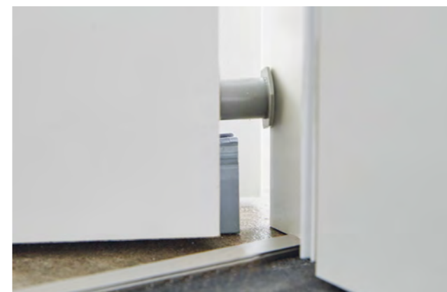
Auslöser für automatisch absenkende Bodendichtung
