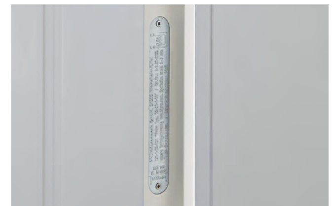
Funktionskennzeichnung im Türfalz
